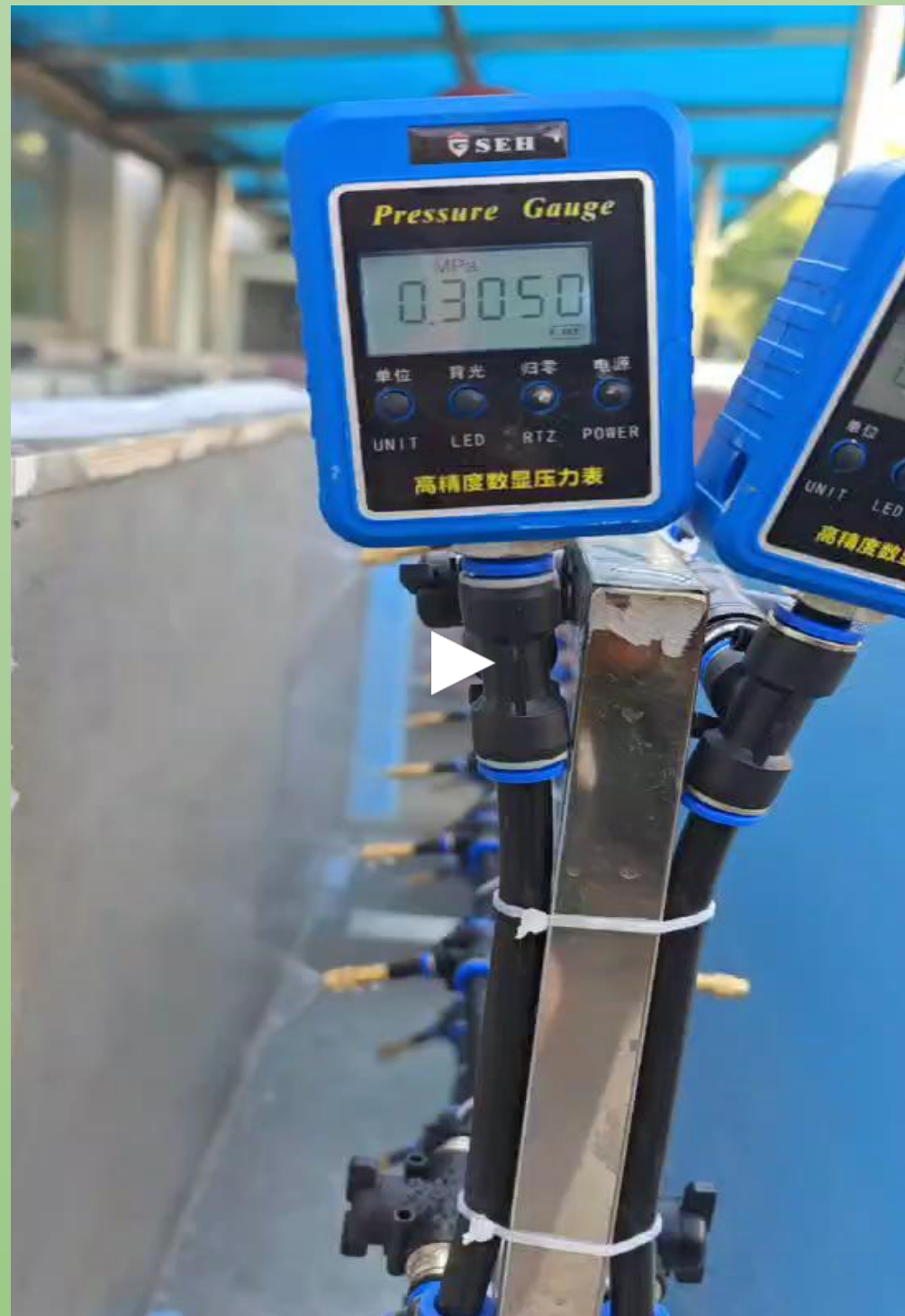
灌浆料淋水试验（系统内侧无渗漏）
